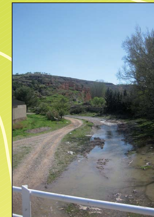
2. PUENTE DE LA CARRETERA
