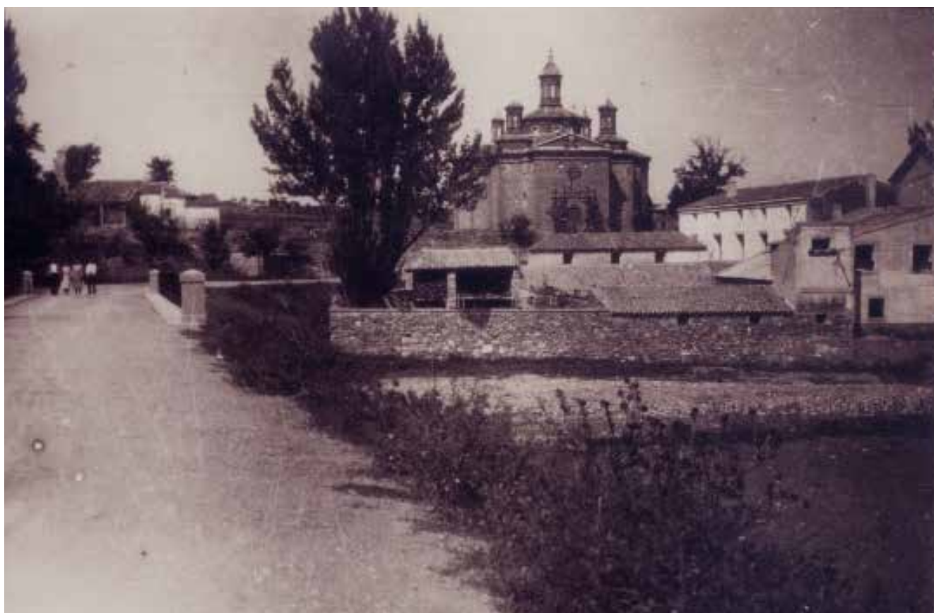
Carretera, puente, fabrica de harinas y al fondo a la derecha traseras de fabricas de persianas y de telares, con un piso. Años 30
