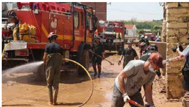
Azuara: trabajos de limpieza por UME y vecinos
