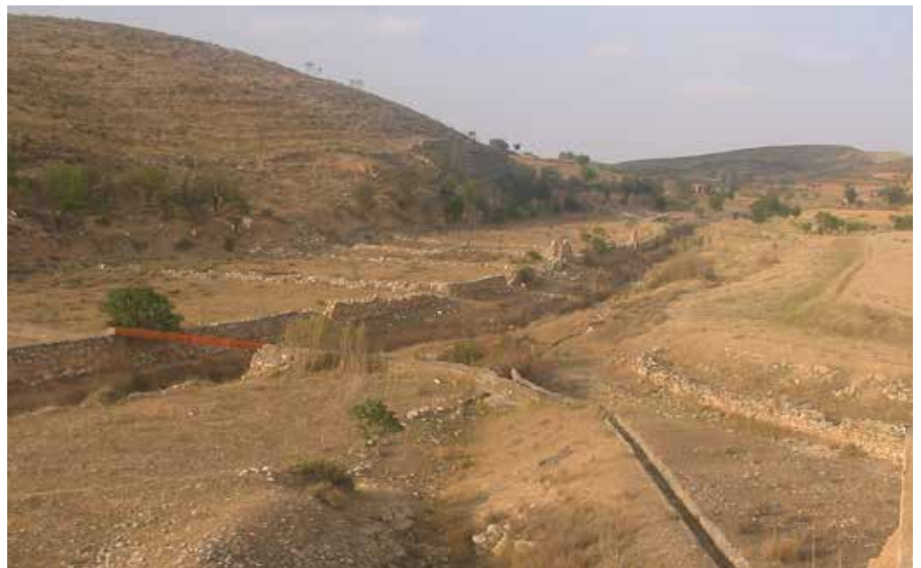
2ª zona tras balsa y molino: acequia y canal para llevar el agua al otro lado del río y huertos
